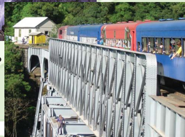
Ponte São João (Ligação entre Curitiba e Litoral).
